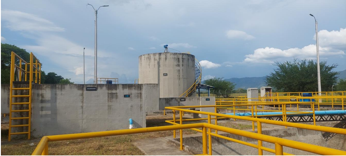
Estado de la PTAR Guarinocito
