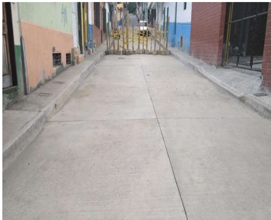
CONSTRUCCIÓN DE PAVIMENTO
