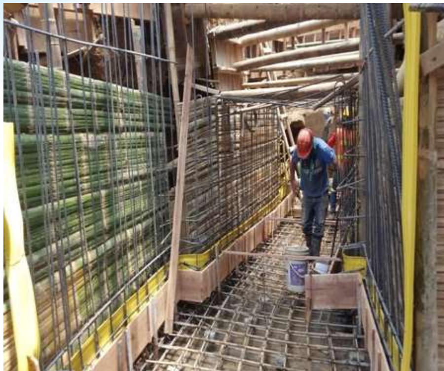
INSTALACIÓN DE ACERO DE REFUERZO
