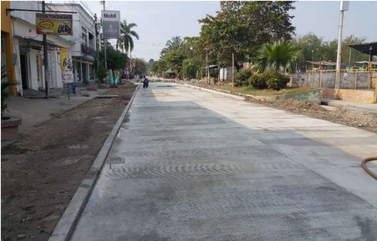
PAVIMENTO VÍA CRA 2.
